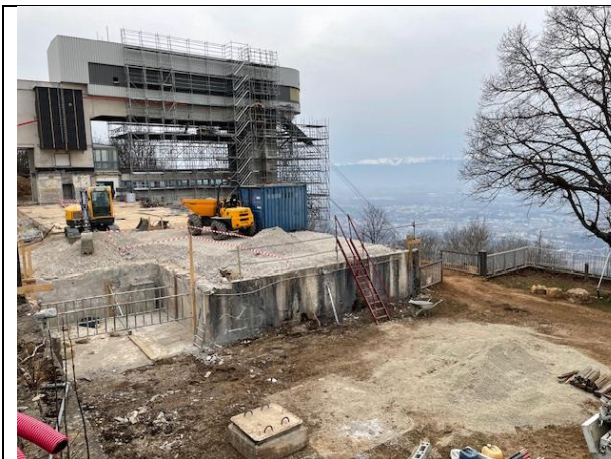
Mars 2022 - les échafaudages se mettent en place
