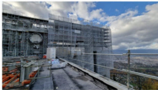
Le chantier de cet équipement emblématique du Grand Genève, qui rouvrira ses portes à la mi-juillet 2023. Photo La D. / J. P.
