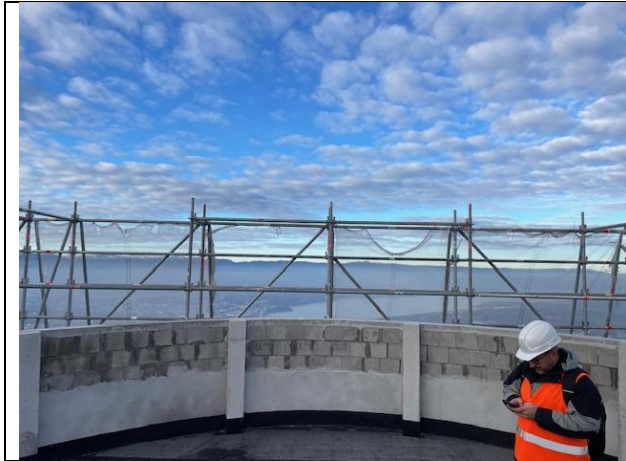
Le toit terrasse
