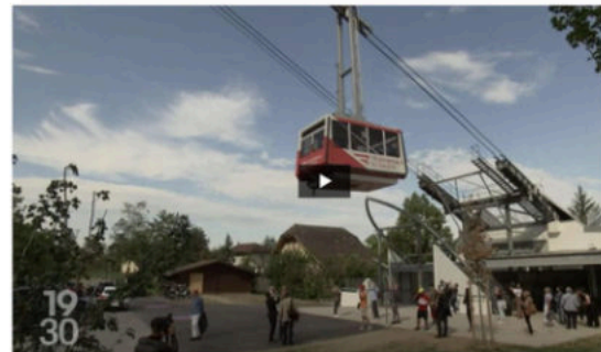
Après deux ans de travaux, le téléphérique du Salève, aux portes de Genève, est à nouveau en service. / 19h30 / 2 min. / le 12 septembre 2023
