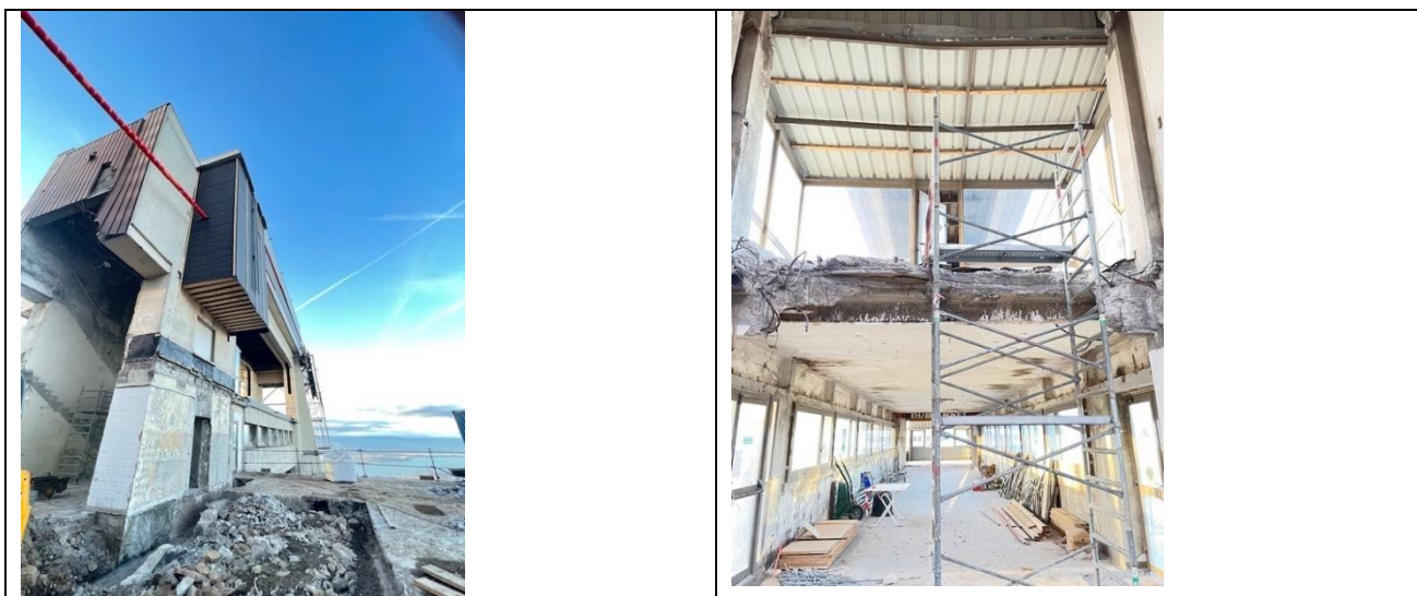
Février 2022 – les démolitions contiennent, l'espace pour le mur d'escalade se dessine
