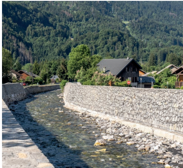
Digue du Clévieux après aménagement
